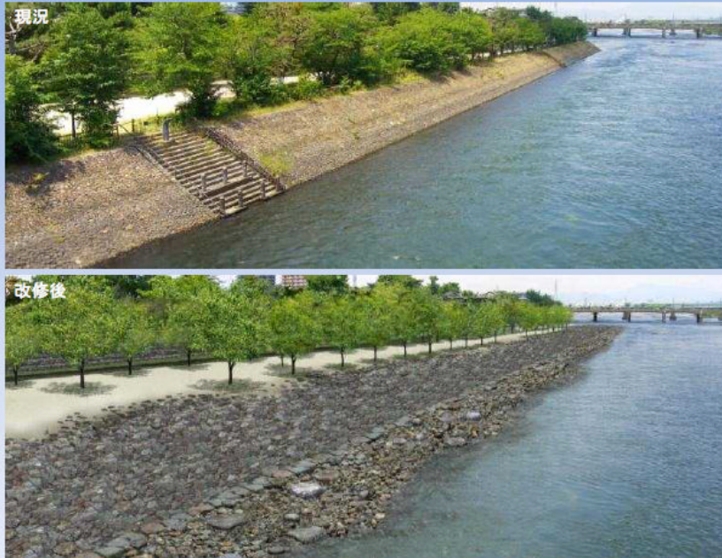
宇治川左岸護岸(朝霧橋より下流を望む)
